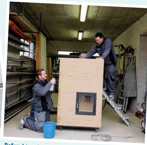
Befeuchten des Lehmverputzes
