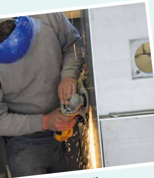
die Schweißnaht schleifen
